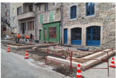
Les nouvelles terrasses en novembre. le dauphin   lib  r  
