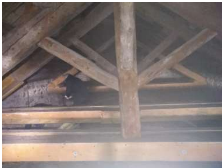
Visite des combles de l'église de St Agrève le 10/11/20
