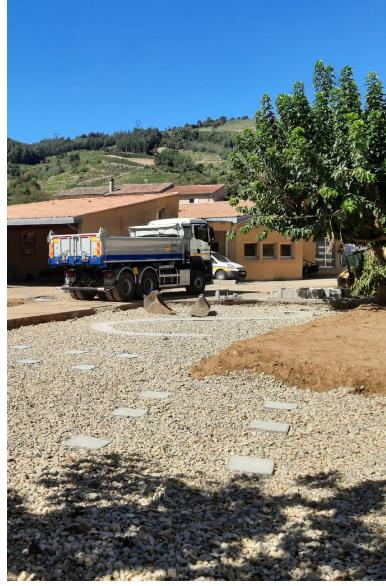
Découpe du bitume, décaissement, apport de terre végétale, création des fosses d'arbres, positionnement des plots béton pour le mobilier, etc.
