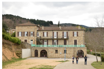
Photo de la salle polyvalente existante
