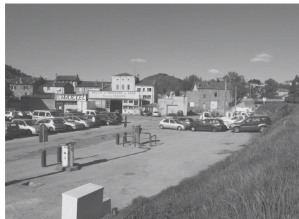
Vue de la partie sud de la digue
