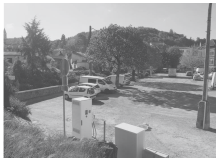
Vue depuis la digue
