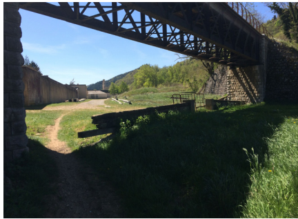
Vue sur le site et pont de la Dolce Via
