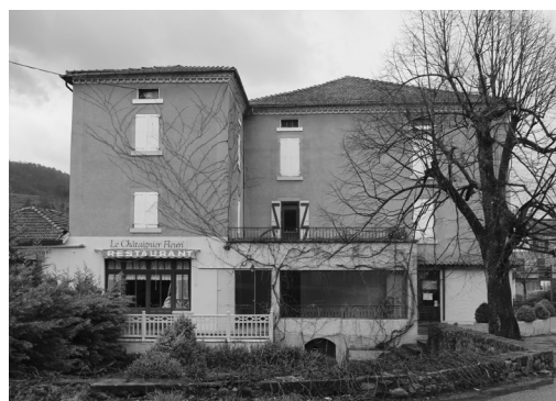
Entrée de ville Nord, ancien Hôtel-Restaurant
