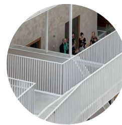
Passerelle piétonnière en acier-béton pour les logements construits (réf : Vincent PARREIRA/AAVP - 69 logements et un gymnase, 2016)
