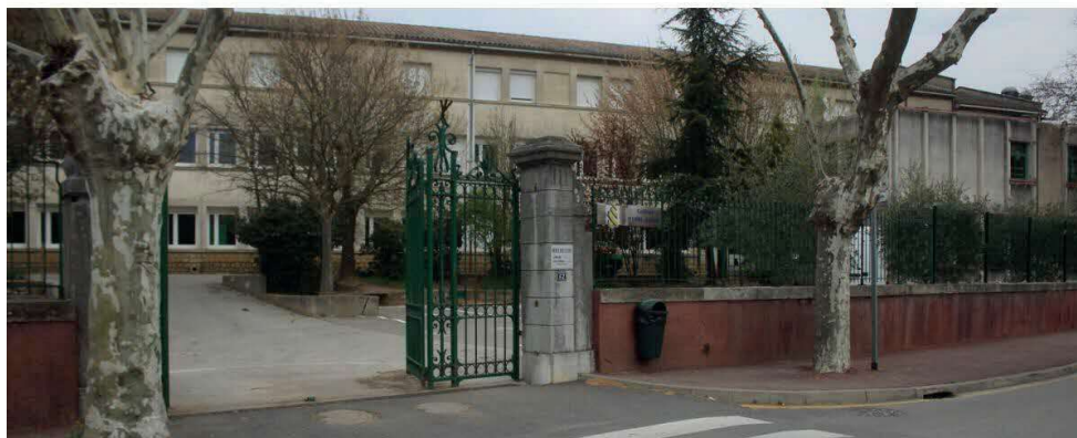
Image actuelle de l'ancien collège de Vallon-Pont-d'Arc Crédit de l'image : https://cdn-s-www.ledauphine.com/images/17A1CC1A-C3BD-4551-9232-63D4A60E2D15/MF_contenu/du-nouveau-a-l-ancien-college-1459529169.jpg
