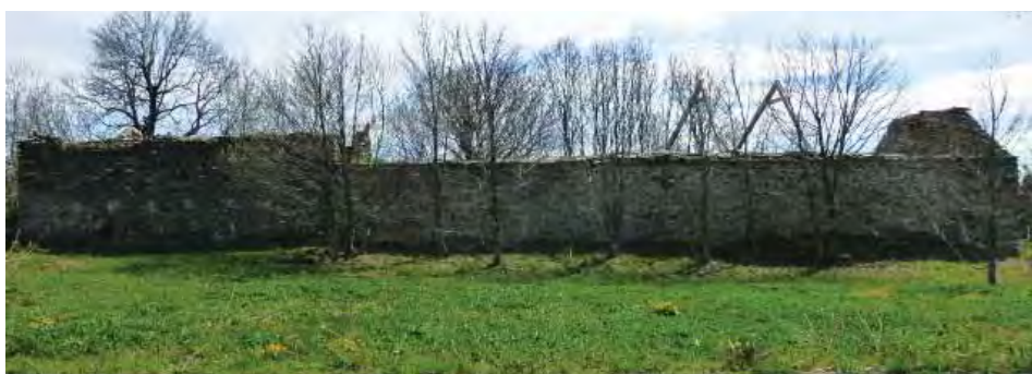
Ruine, mur nord
