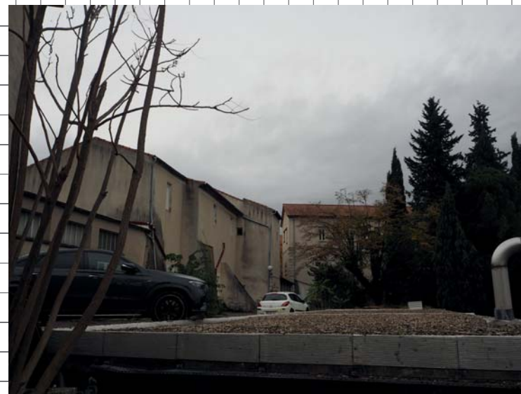
VUE DE L'ARRIÈRE DE L'ANCIENNE CHAPELLE, AVEC LE TOIT DE L'ANCIENNE CHAMBRE FUNÉRAIRE
