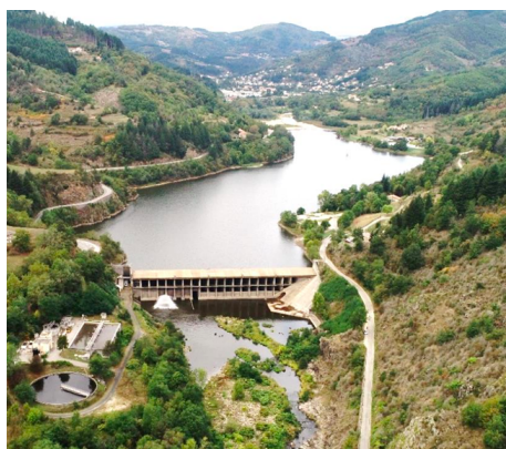
FIGURE 50 – Photographie aérienne actuelle du barrage des Collanges ( Comité français des barrages et réservoirs )
