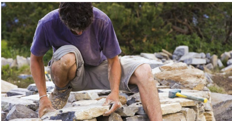
Construction de la « Tour à eau » de Gilles Clément sur le parcours artistique le Partage des eaux.
