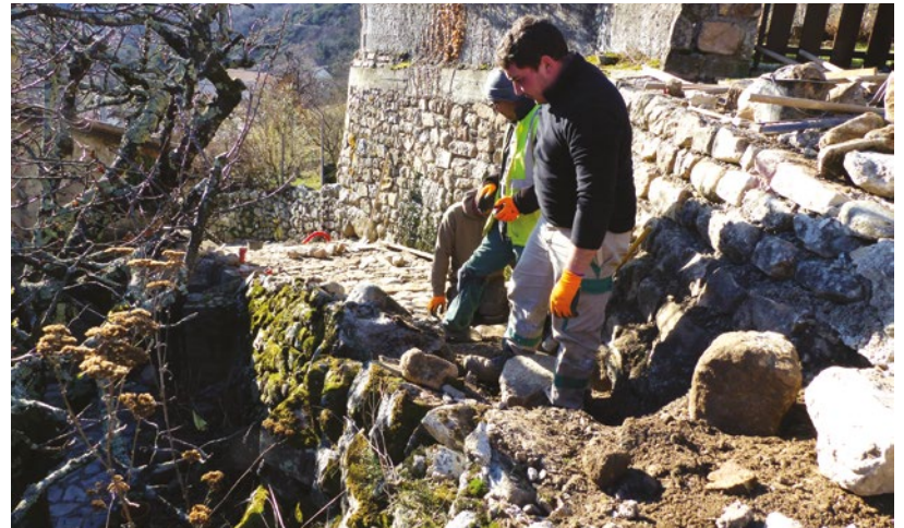
De haut en bas et de gauche à droite : calade de Loubaresse ; calade Sainte Marguerite ; restauration d'une calade à Bise lors d'un chantier école.
