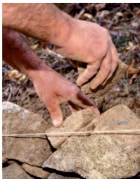
La construction d'une structure de soutènement en pierre sèche ne s'improvise pas. Elle nécessite de connaître la nature du remblai (terres) à soutenir et celle du sol où l'on posera le mur (coefficient de glissement), de repérer les écoulements d'eau afin de les maîtriser, de réunir un volume suffisant de pierres "tous modules", de dimensionner le mur (longueur / hauteur / épaisseur à la base et fruit).
