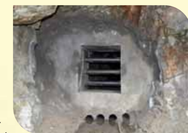
Lucarne à barreaux
