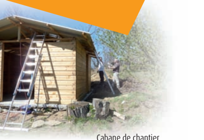
Cabane de chantier
