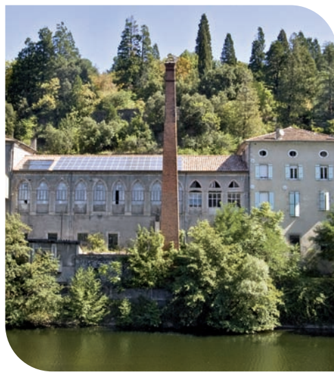
Cheminée d'usine aux Ollières
