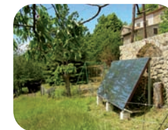
Panneau solaire au gîte du Jal
