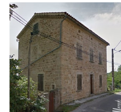
Construction de grès orange à Payzac
