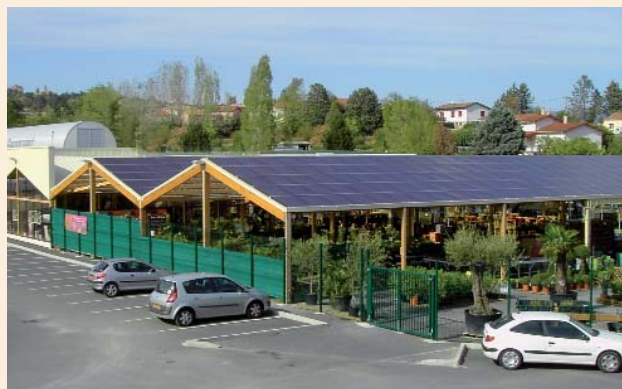
Installation sur bâtiment commercial
