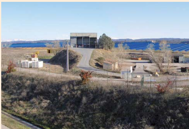
Centrale photovoltaïque au sol sur ancienne décharge
