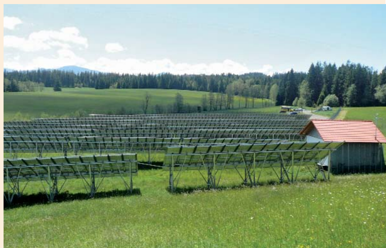
Centrale photovoltaïque au sol en zone agricole
