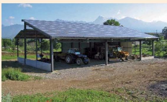
Installation sur bâtiment agricole
