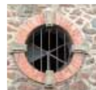
Détail d'encadrement en brique
