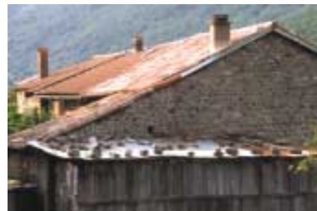
Toit en tôle sur une remise
