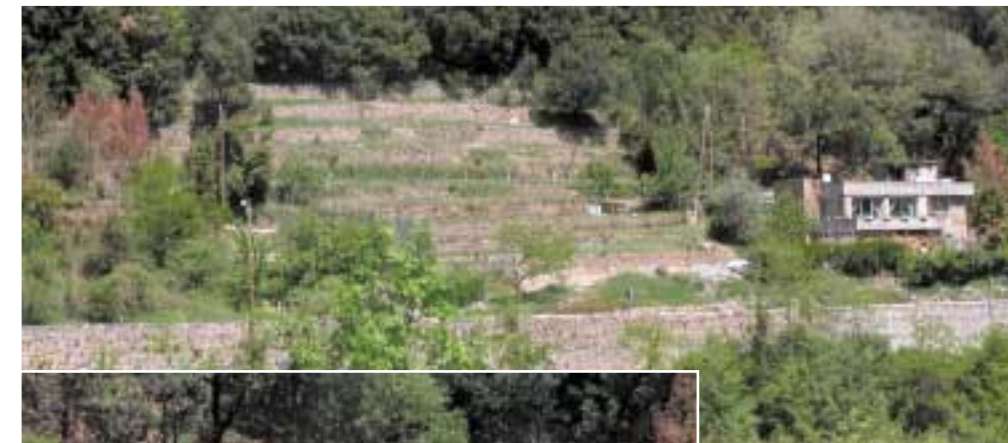
Maison à Meyras. Les verticales sont en pierre de pays par mimétisme avec l'architecture vernaculaire. Les bandeaux horizontaux en béton de la toiture terrasse sont dans la continuité des soutènements des terrasses du terrain.
