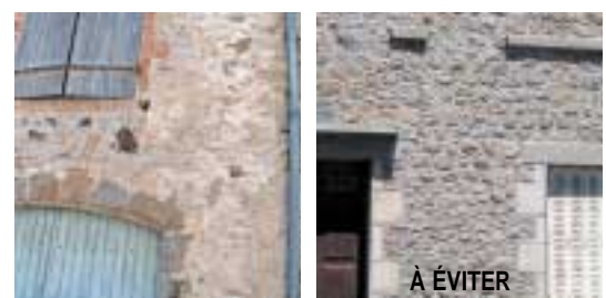
Enduit de jointoiment
