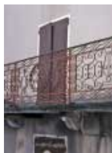
Balcon sur corbeaux en pierre, Jaujac
