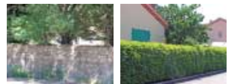
Mur en pierre
