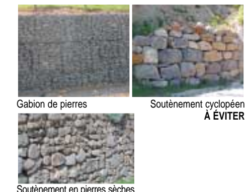
Soutènement en pierres sèches
