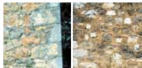
Chaîne taillée et remplissage
