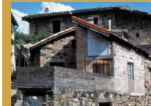
Matériaux divers, Pont-de-Labeaume
