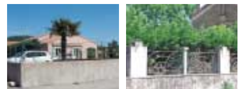
Mur en béton et grillage
