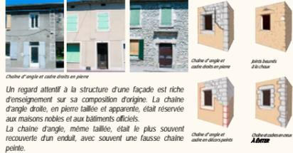
Un regard attentif à la structure d'une façade est riche d'enseignement sur sa composition d'origine. La chaîne d'angle droite, en pierre taillée et apparente, était réservée aux maisons nobles et aux bâtiments officiels. La chaîne d'angle, même taillée, était le plus souvent recouverte d'un enduit, avec souvent une fausse chaîne peinte.
