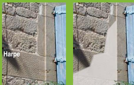
Encadrement droit. La harpe est en retrait pour que l'enduit vienne se caler contre la pierre et la souligner. Noter la harpe bouchardée (piquetée) pour la bonne accroche de l'enduit de finition.
