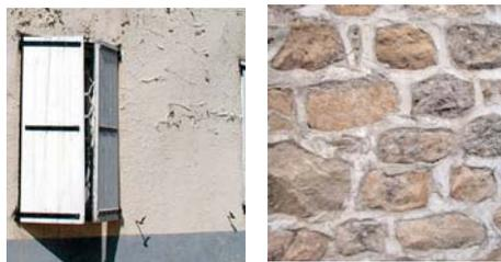
Revêtement ou joints étanches sur maçonnerie de pierre. L'humidité reste captive dans le mur et dégrade l'enduit.
