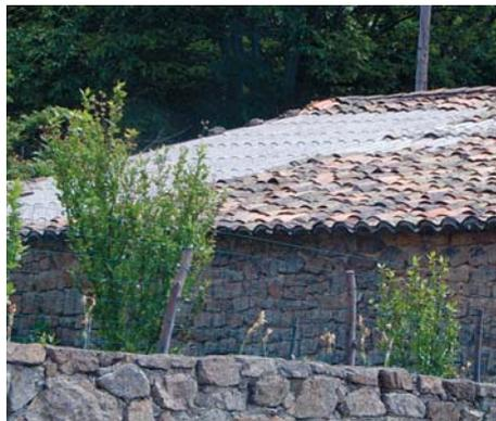
Mélange de tuiles et de tôle, réparation "discutable".
