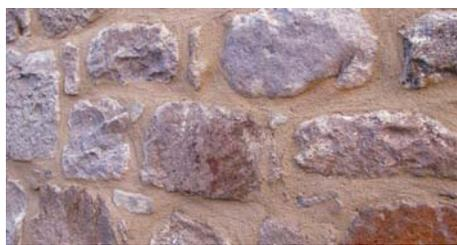
Enduit de jointolement à la chaux.
