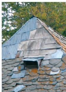
Réparation de la toiture de lauzes à l'aide de tôle ondulée
