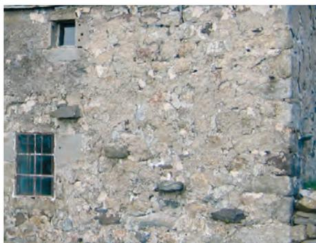
Exemple d'enduit de jointoiment dit "enduit à pierre vue" ou "enduit à tête vue".
