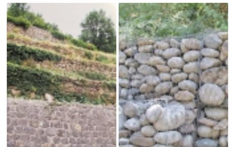
Murs de soutènement maçonné et en pierres sèches, Beauvène
