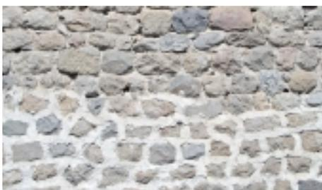
Pierres de blocage dressées en lits horizontaux. La partie inférieure du mur présente des joints largement "beurrés" à la chaux. Cette technique a l'avantage de protéger la pierre des intempéries et l'intérieur de la maison de l'humidité.
