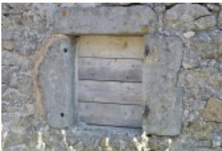
Saint-Cierge-la-Serre. Petite ouverture avec linteau, jambages et appui en pierres d'une seule pièce.
