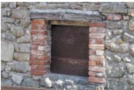
Saint-Cierge-la-Serre. Même ouverture avec linteau en bois et jambages en briques. La forme régulière de la brique permet une réalisation correcte et rapide de l'ouvrage dans sa finition.
