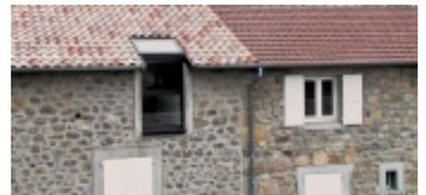
La création d'ouverture, peu importe sa forme, doit tenir compte de la composition générale de la façade. L'utilisation de chassis de toiture peut être une solution à envisager lorsque les ouvertures en façade ne sont pas possibles, notamment pour l'aménagement de combles. Leur mise en oeuvre doit être soignée.
