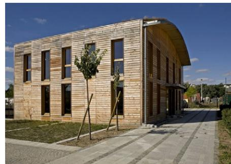
Recours à des éco-matériaux : chaussées en béton intégrant 40% de fraisats d'enrobés (matériau 100 % recyclable, restituant 40% de lumière en plus, par comparaison avec un béton traditionnel, trottoirs en stabilisé, sans liants chimiques)
