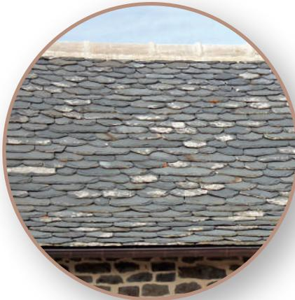
**Toit de lauzes de phonolite avec faitage en trachyte : Chaudeyrolles.** *Les deux matériaux associés ont fréquemment été employés sur le Massif du Mézenc.*
