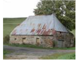
Pierre et tôle ondulée en couverture.
