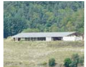
Charpente lamellé-collé et bac acier.
