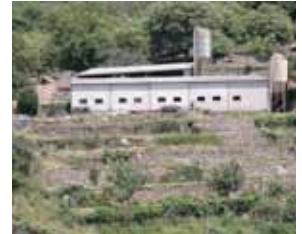
Préfabriqué béton et amiante ciment.
