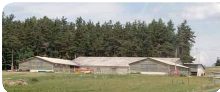
Grand volume bâti, compact et adapté au site.
