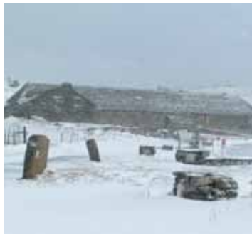
Ferme des Sucs (secteur au climat très rigoureux sous la neige). Bâtiment ramassé sur lui-même, constitué de matériaux solides et pérennes (pierre, lauze).
