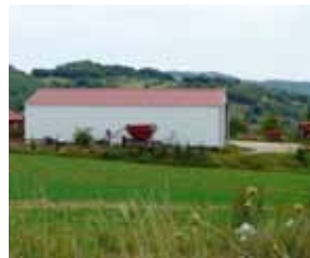
Bac acier en mur et couverture.
