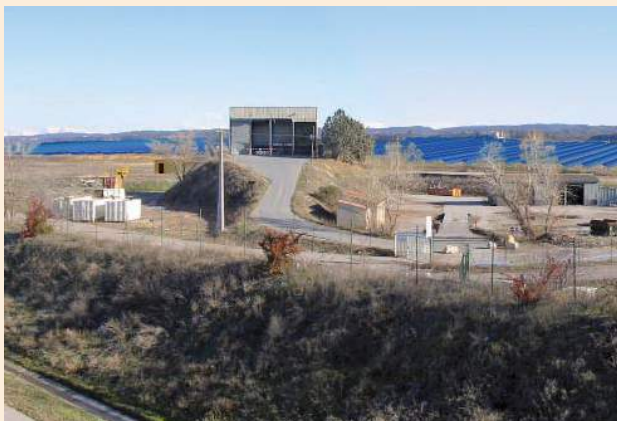
Centrale photovoltaïque au sol sur ancienne décharge
