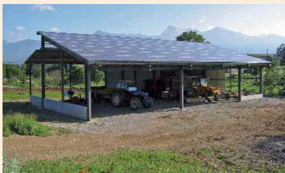
Installation sur bâtiment agricole
