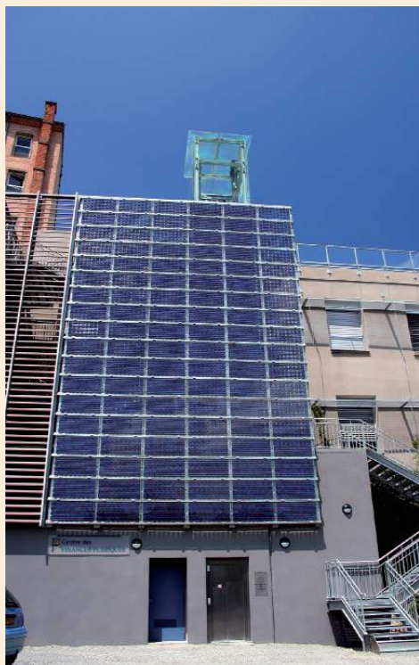
Intégration verticale de panneaux photovoltaïques
